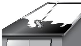
Очистить поверхность от мусора и пыли, при ремонте старых крыш полностью удалить старое кровельное покрытие. Установить карнизные и фронтовые планки. Загрунтовать основание битумным праймером.
