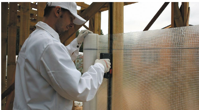
Рис. 19. Монтаж пароизоляционной пленки
