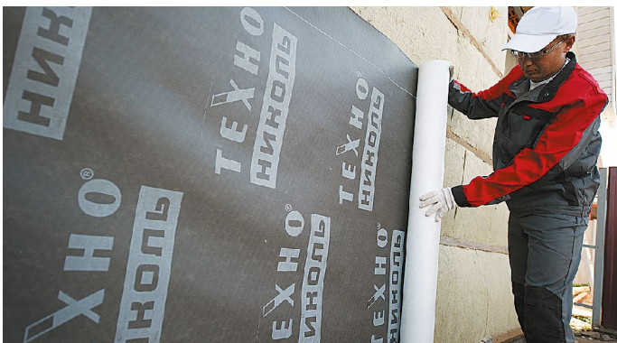
Рис. 5 а. Монтаж ветро-, влагозащитной мембраны
