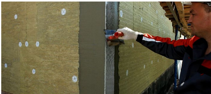
Рис. 35. Установка усиливающих профилей на углах здания
