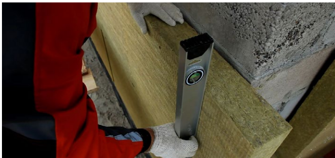
Рис. 29. Приклейка плиты тепло-, звукоизоляции к стене
