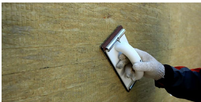
Рис. 32. Шлифовка стыков плит теплоизоляции наждачной бумагой
