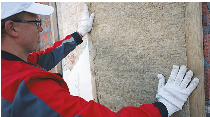
Рис. 2. Монтаж теплоизоляционных плит в вертикальный каркас
