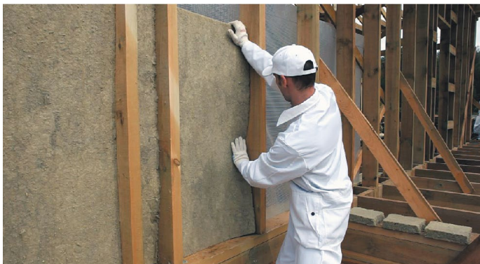
Рис. 20. Монтаж теплоизоляционных плит
