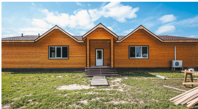
Рис. 22. Монтаж облицовочного материала
