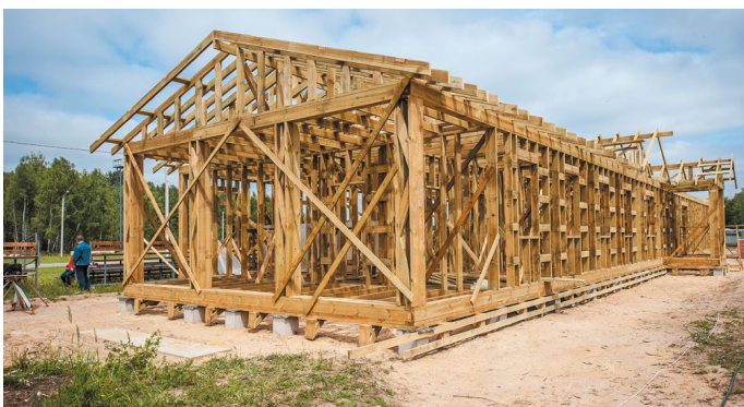
Рис. 18. Установка деревянного каркаса
