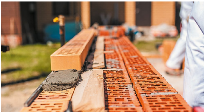
Рис. 14 б. Монтаж внешней версты после установки гибких связей
